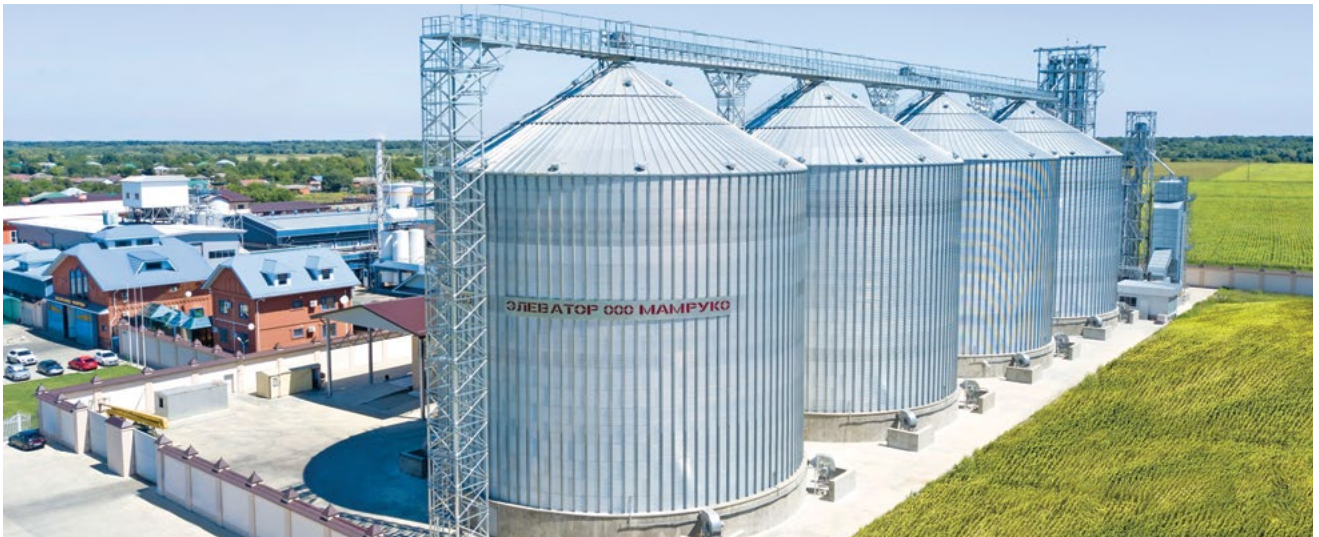
ЭЛЕВАТОР ПРИ МАСЛОЗАВОДЕ ДО 47 000 ТОНН ООО «Мамруко», Республика Адыгея
