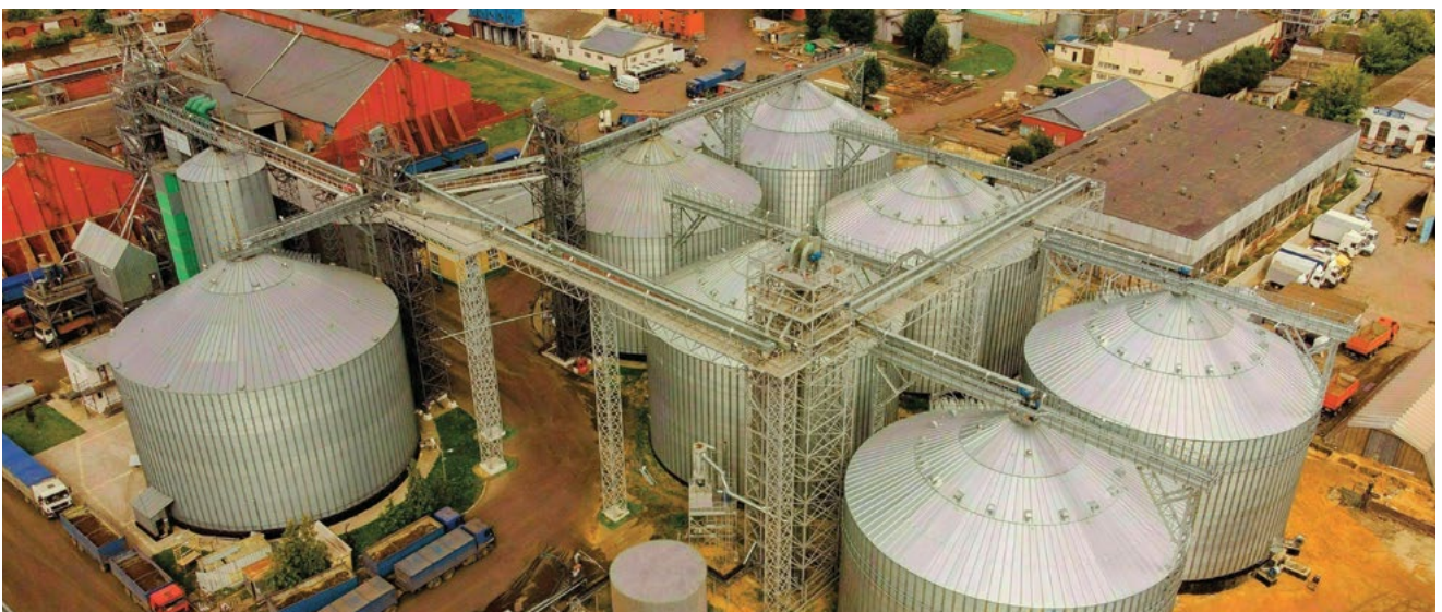
ПРОИЗВОДСТВЕННЫЙ ЭЛЕВАТОР (РАСТИТЕЛЬНЫЕ МАСЛА) ДО 43 500 ТОНН ОАО «Орёлрастмасло», Орловская обл.
