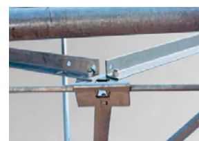
кованые шпренгельные растяжки повышенной прочности
