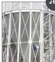
**ЭКСПЕДИТОРСКИЕ СИЛОСЫ ПРЕДНАЗНАЧЕНЫ ДЛЯ НАКОПЛЕНИЯ В НИХ ПРОДУКТА** (зерна, продуктов переработки растительного сырья, отходов переработки растительного сырья, аспирационных отходов и др.) с последующей загрузкой авто и ж/д транспорта самотеком. Емкости могут быть от 4,5 до 1 000 тонн, с разными углами конического дна (45°, 60° и 66°). Экспедиторские силосы устанавливаются на мощные стальные конструкции для обеспечения безопасного проезда под ними транспорта
