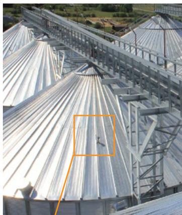
В стандартной комплектации системы вентилирования применены системы дефлекторы ЦАГИ. Их работа основана на использовании пониженного давления, создаваемого ветром. Опционально на кровлю силоса устанавливаются турбодефлекторы – они повышают эффективность вентиляции в 4 раза. Активная головка дефлектора вращается под воздействием ветра, создавая разрежение в вентиляционном канале, что способствует росту тяги
